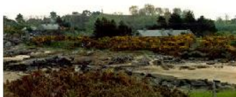
Les maisons du Pont : intégration dans le paysage
