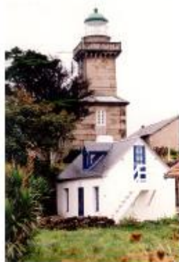
L'accès aux combles par un escalier extérieur
