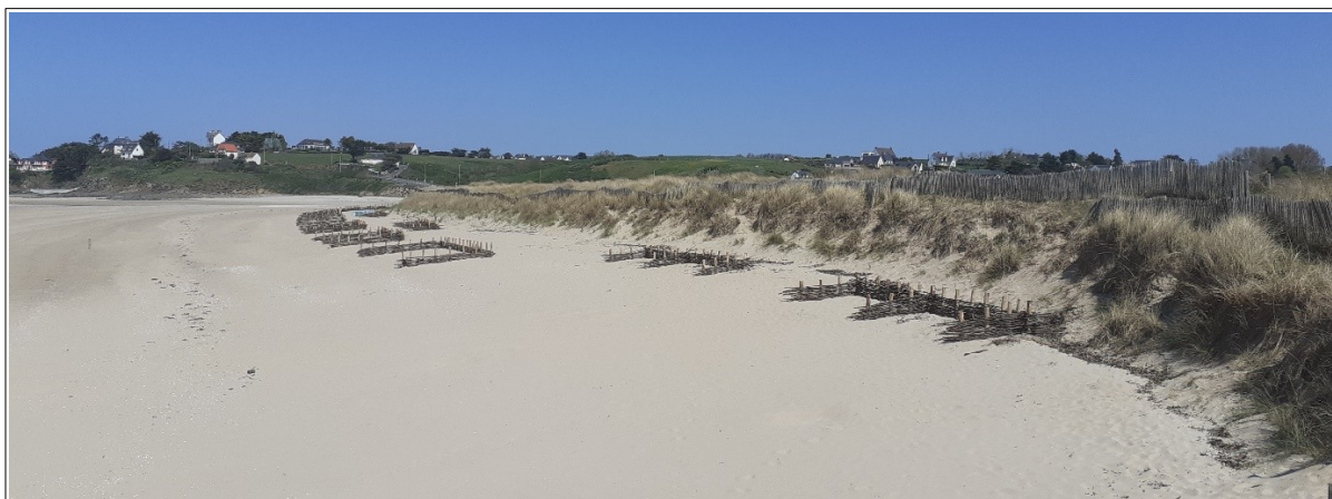
Figure IV.45 : Vue des deux nouvelles fascines au droit de la partie mince de la flèche, au premier plan (Ville de Saint-Pair-sur-Mer).
