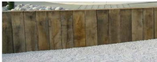
exemple de soutènement réalisé en bastaings bois
