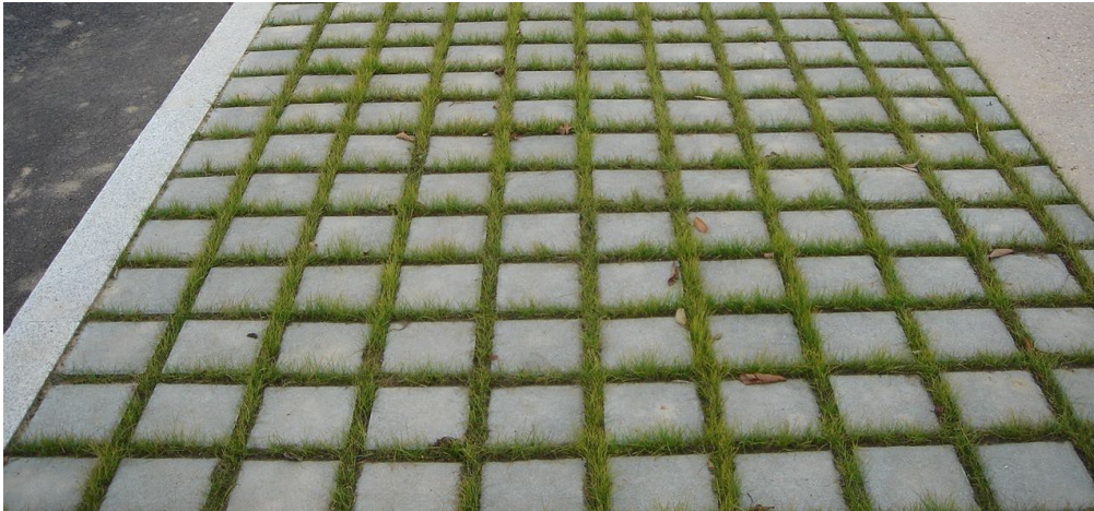
Stationnement perméable : chaussée végétale et pavés joints engazonnés
