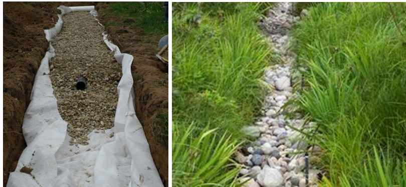
Tranchée d'infiltration noue empierrée
