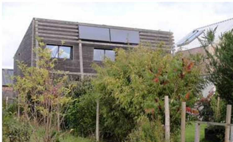
Exemples de matériaux de toiture et de pose de panneaux solaires
