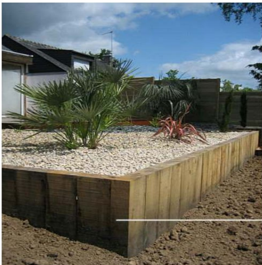
exemple de soutènement réalisé en bastaings bois
