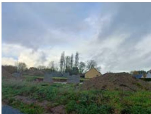
Lotissement en cours de réalisation
